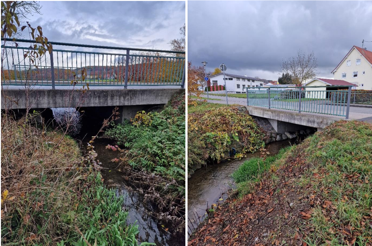
Abbildung 3: Stahlbetondurchlass Fellheimer Straße, links Oberstrom und rechts Unterstrom
