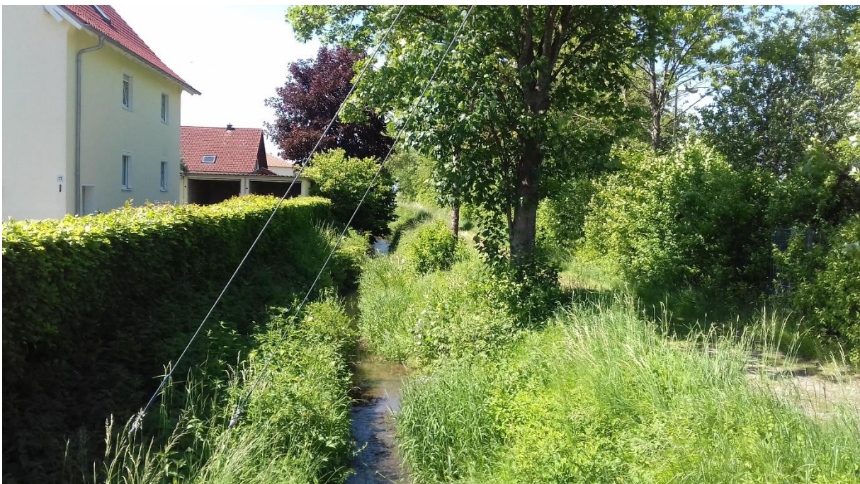
Abbildung 4: Bachlauf von Durchlass Fellheimer Straße, Blickrichtung nach Oberstrom
